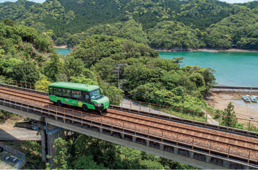
高架区間から海を望む。時速60kmを予定しているが、通常の列車に比べて窓が大きいのでスピード感がある。道路渋滞がないことも運行する上で大切な要素
